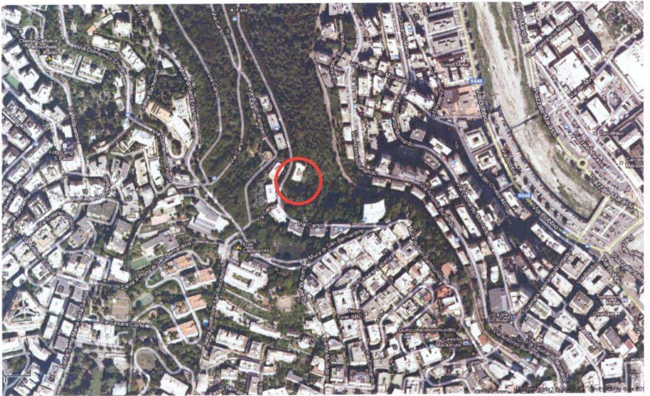
Vista aerea – Individuazione fabbricato Via Carso civ.13
